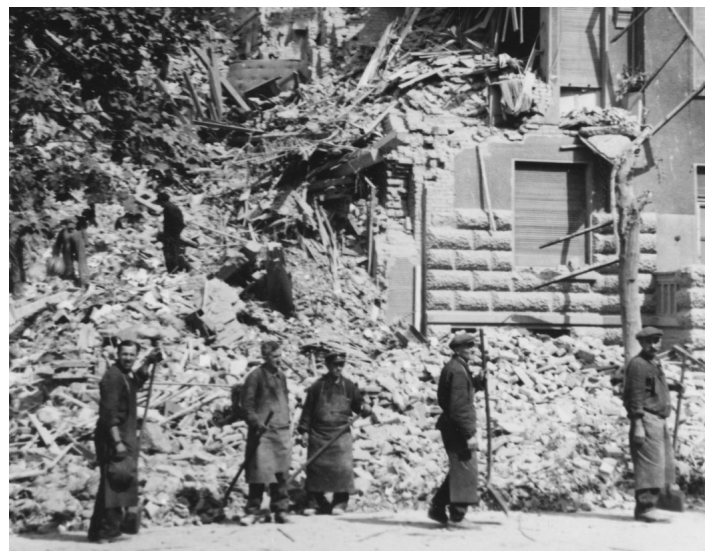
Aufräumarbeiten Scheffelstraße 10 nach dem Angriff
