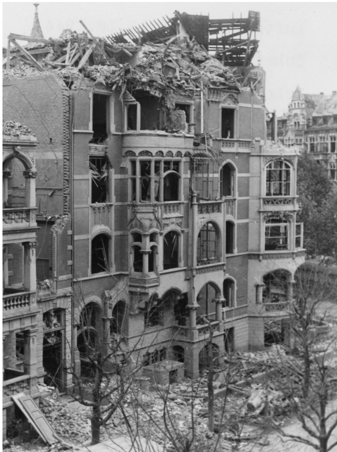
Zerstörungen in der Scheffelstraße 1-2 im Februar 1945
